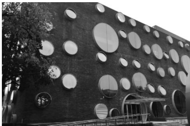
图1 北京大学附属小学体育馆工程
